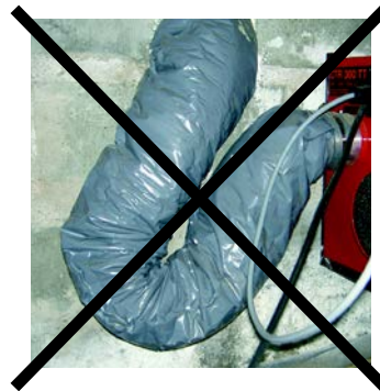
Falsche Montage, zu kleiner Biegeradius
