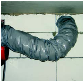
Korrekte Montage, großer Biegeradius.
